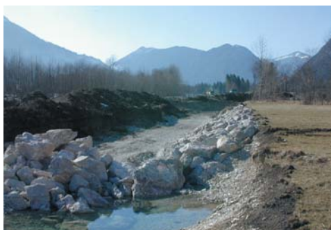
Foto 3 und Foto 4: Rodungen linksufrig und Einbau der neuen Ufersicherung an der Vils, ganz links zu sehen das alte, eingeengte Flussbett (ARGE Limnologie)
