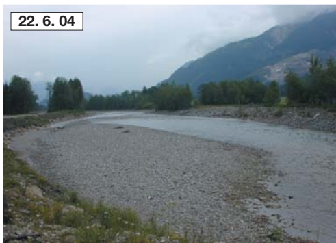
Foto 5 bis Foto 8: Entwicklung der Vils im Projektgebiet nach der Aufweitung und Einbringung von Sohlsubstrat (ARGE Limnologie)
