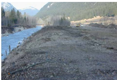
Foto 3 und Foto 4: Rodungen linksufrig und Einbau der neuen Ufersicherung an der Vils, ganz links zu sehen das alte, eingeengte Flussbett (ARGE Limnologie)
