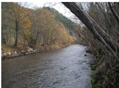
Foto 1: Durchgehende Blockwurfsicherung im Jahr 2001 vor Umsetzung der Maßnahmen an der Vils, hier in Kombination mit Holzpiloten (IHG)
