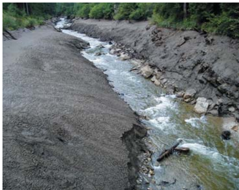
Kraftwerk Edelschrott nach der Spülung
