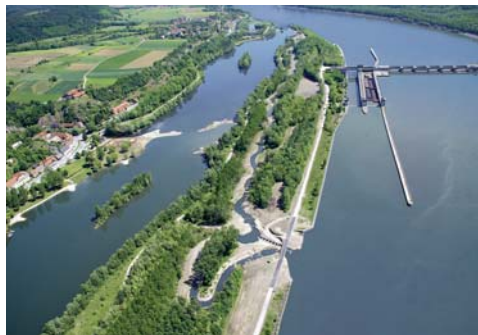
FWH Melk nach Fertigstellung 2007
