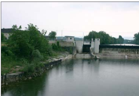
Wehranlage Greinsfurth-Projekt, Fischaufstiegshilfe rechtsufrig Foto: Gravogel
