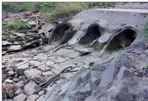
Rohrdurchlass Schallemersdorf bei Grimsing Foto: Gravogl
