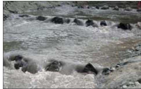
Wulka, aufgelöste Rampe
