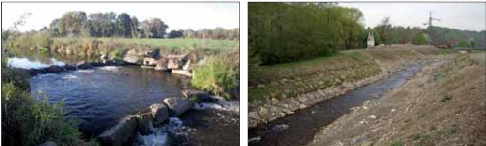
**Abb. 9:** Links: Obere Riegelrampe an der Leitenbach-Mündung; rechts: asymmetrische Rampe, die auch für Goldsteinbeißer passierbar ist (Gamplitzbach-Mündung, Südsteiermark)
