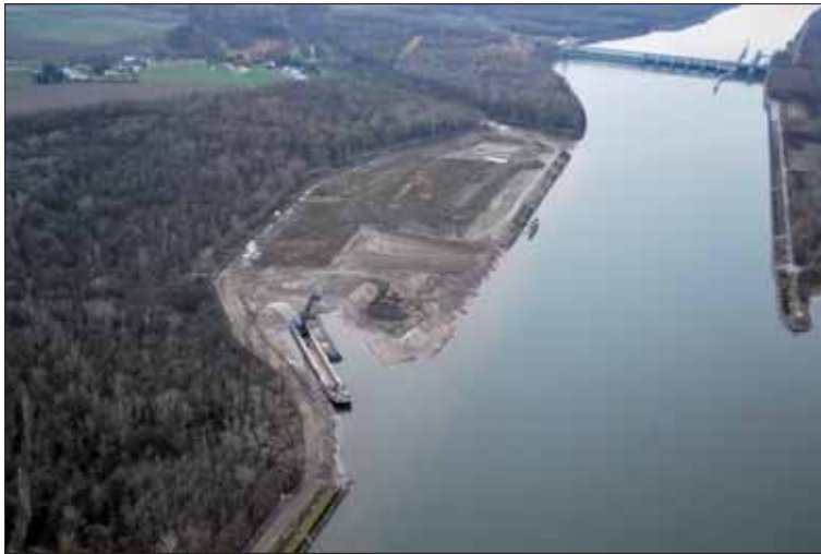
Abb. 7: Stromab der Innbachmündung ist ein durchströmter Donau-Nebenarm mit hohem Potenzial als Huchen-Lebensraum in Bau. Die Rodungsfläche lässt die Lage und Ausdehnung dieser Maßnahme erkennen. Im Hintergrund KW Ottensheim-Wilhering. Foto: Linz AG
