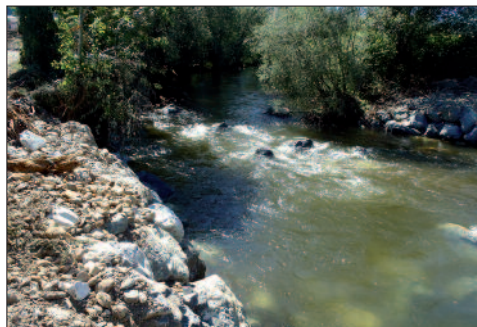
Kainach: Aufgelöste Sohlschwelle
