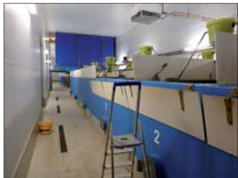
Kreislaufanlage für die Produktion von Afrikanischem Wels ( Clarias gariepinus ) in Sachsen
