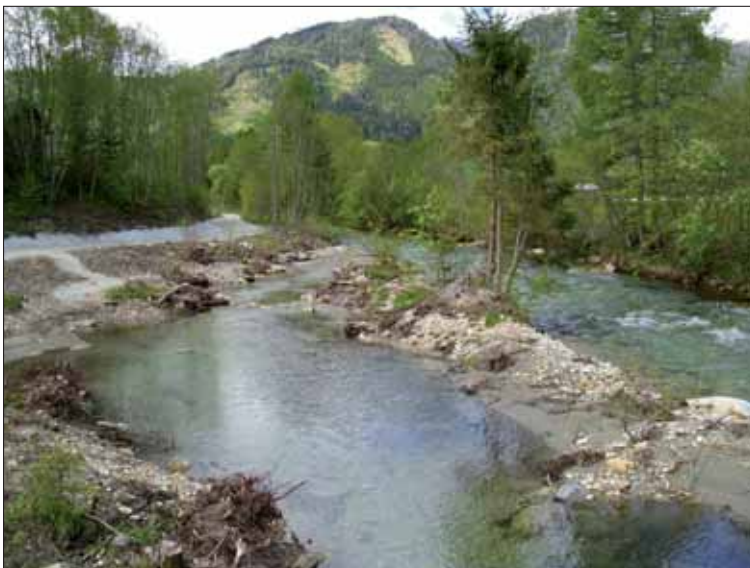
Beispiel einer Flussaufweitung im Lungau: Taurach in Mauterdorf kurz nach Fertigstellung 2010.
