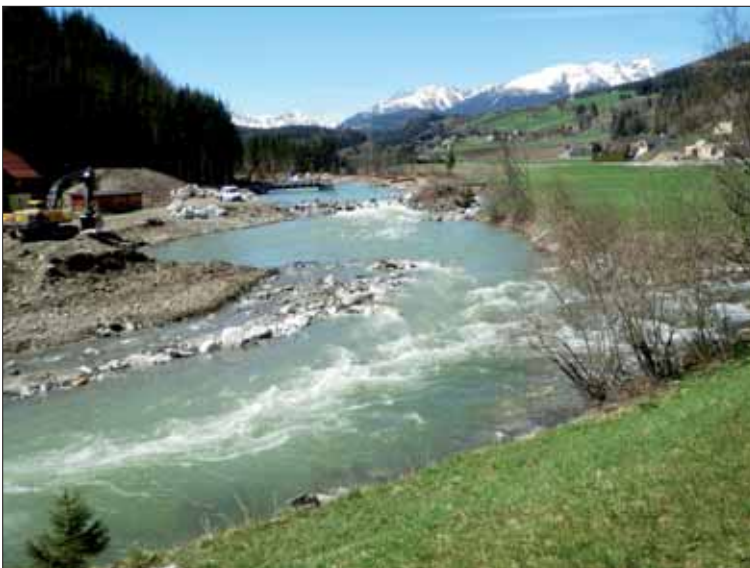
Aktuelle Arbeiten an der Taurach im Bereich des Taurachknies bei Tamsweg.
