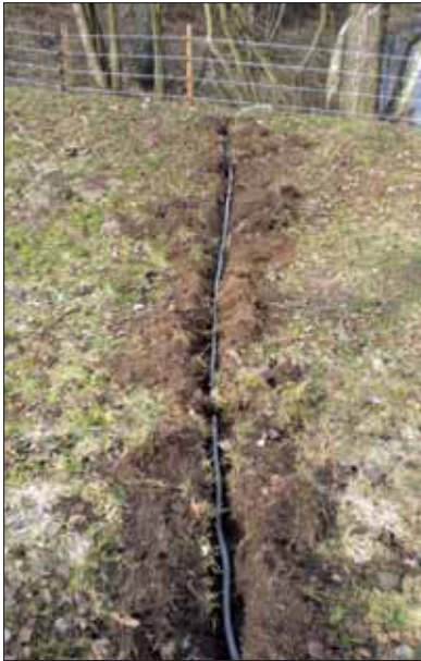
Abb. 1: Verlegung flexibler Kabelschutzrohre zwischen einzeln gezäunten Teichen
