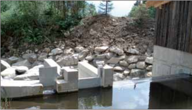
Abb. 1: Das in diesem Sommer gebaute »Tiroler Wehr« mit einem »Coanderrechen«, der angeblich besonders wartungsfrei sein soll. Ganz links im Bild der Wehrschütz mit der Öffnung für das Restwasser. Darüber der Blechkasten, in den die Schützentafel – elektrisch gesteuert – hochgezogen werden kann.
