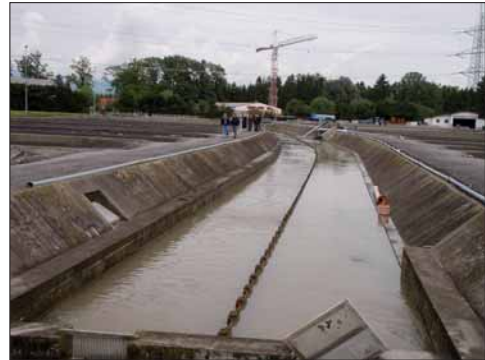
Salmonidenproduktionsanlage Güfel, Meiningen Alle Fotos: A. Jagsch
