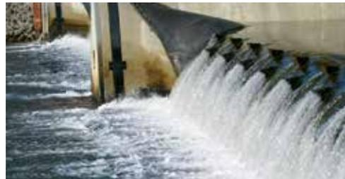
Überströmtes Schlauchwehr mit geringem Unterwasserstand
