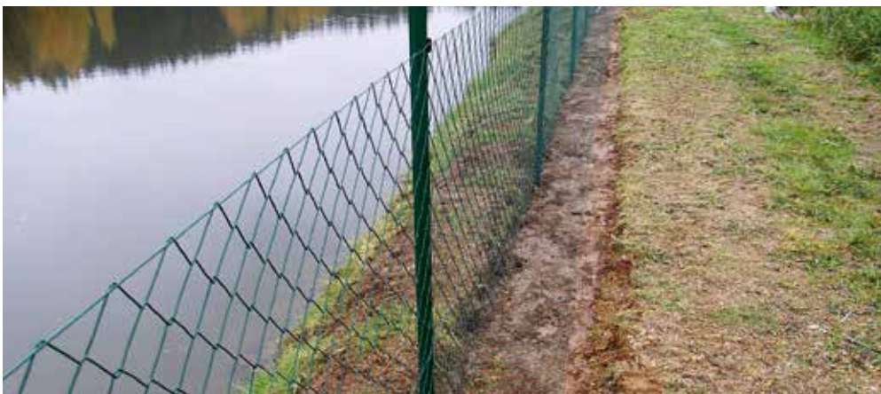
Abbildung 2: Der ca. 25 cm nach außen umgeknickte Maschendrahtzaun in der vorgebaggerten Künette (© Günther Gratzl)
