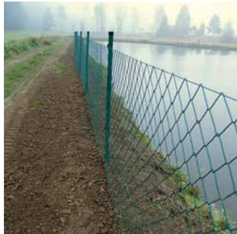
Abbildung 3: Detailansicht der fertigen Einzotterung mittels Vorabsiebmaterial 0/32 aus gebrochenem Schotter (Grädermaterial). Dieses Material lässt sich gut verdichten und bildet mit dem nach außen umgeknickten und eingeschütteten Zaun eine sichere Barriere gegen das Eindringen (© Günther Gratzl)
