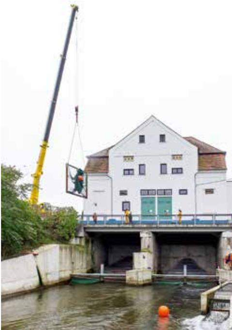
**Abbildung 2** – Einbau eines Hamen
