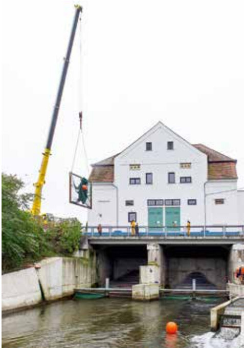
Abbildung 2 – Einbau eines Hamen © Andreas Heddergott / TU München
