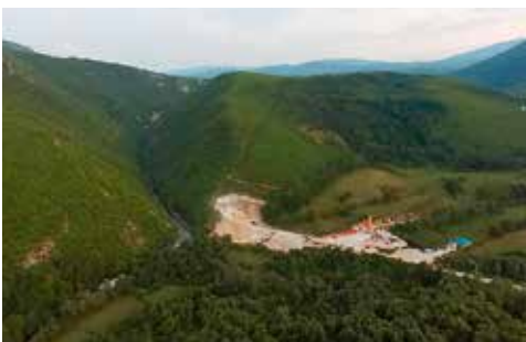
Das Medna Projekt an der Sana, von dem Energieunternehmen Kelag gebaut.
