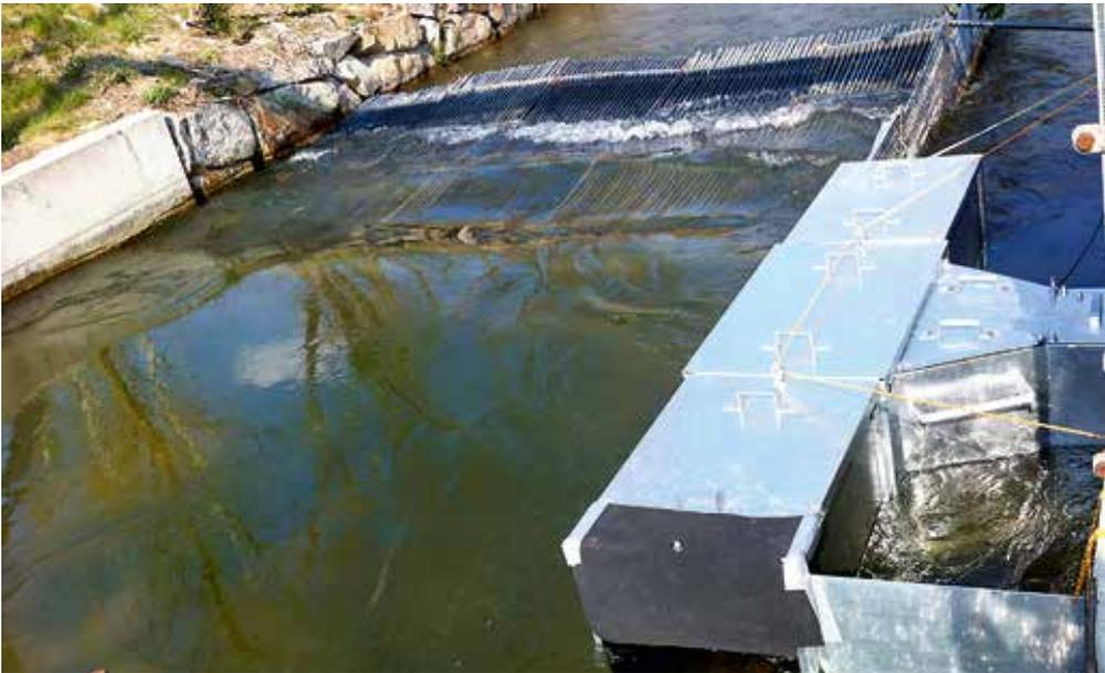
*Videomonitoringsystem der ARGE FishCam in der naturnahen FWH beim Kraftwerk Melk an der Donau in Kombination mit einem Fischwehr mit 1 cm Stabweite (Mühlbauer et al. 2003, Zitek et al. 2009).*
