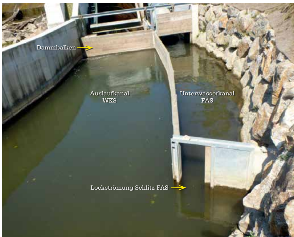
Abb. 4: Einstiegsschlitz in den Unterwasserkanal der FAS.
