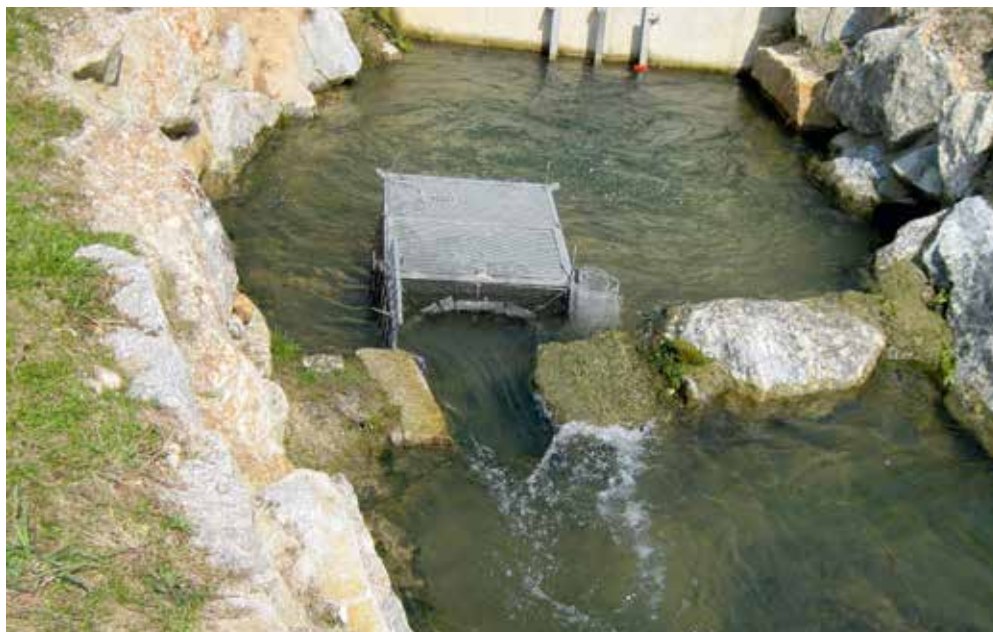
Abb. 9: Reuse im Beckenpass Atzenhofer
