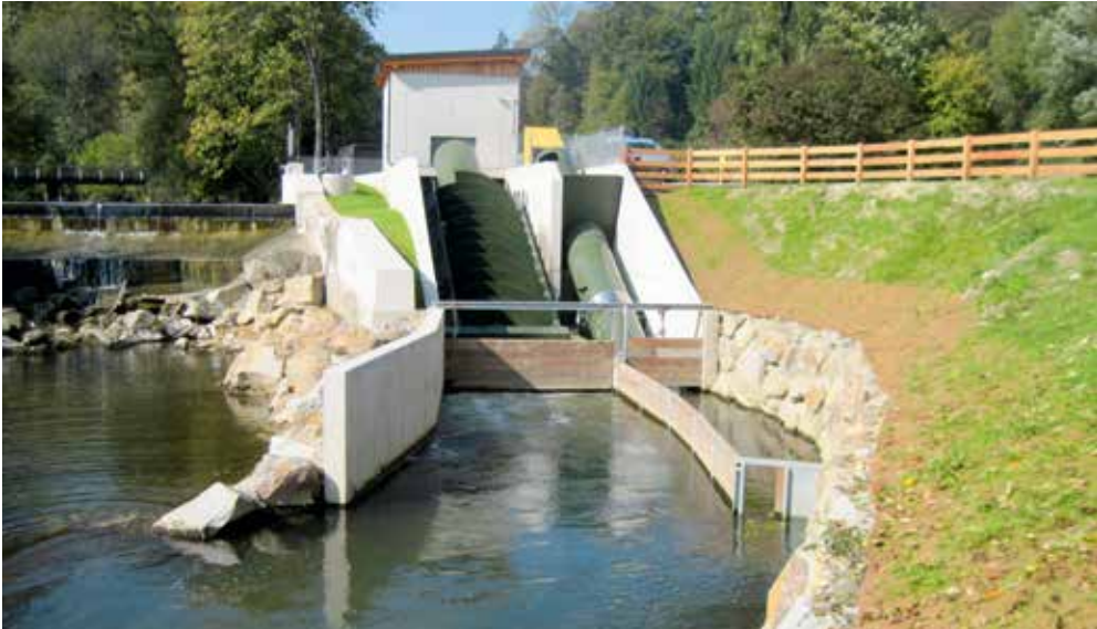
Abb. 1: KW Pilsing an der Url mit Wasserkraftschnecke und getrennter Fischaufstiegsschnecke.
