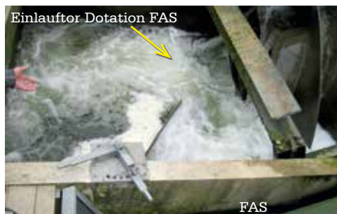
Abb. 2 und 3: Dotationstor hinter der FAS (li) und unterwasserseitiger Einstieg in die FAS (re).
