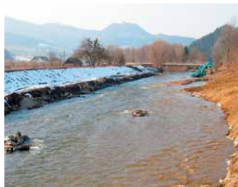
Abb. 9: Baumaßnahmen zur Restrukturierung bei Altach
