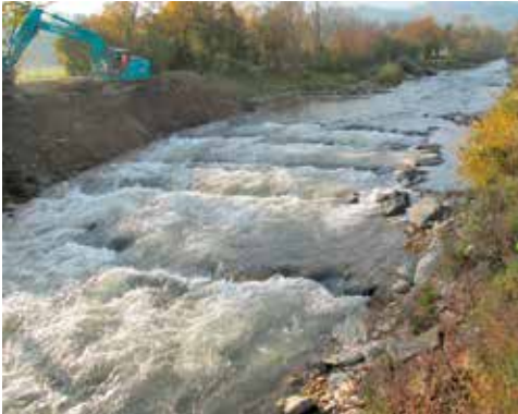
Abb. 4: Zu einer Sohlrampe umgebaute Sohlstufe bei Mettersdorf
