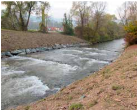
Abb. 2: Zu einer Sohlrampe umgebaute Sohlstufe Blaiken
