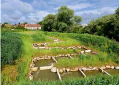
FAH Rennmühle an der Feistritz bei Fürstenfeld Foto: P. Weilgony
