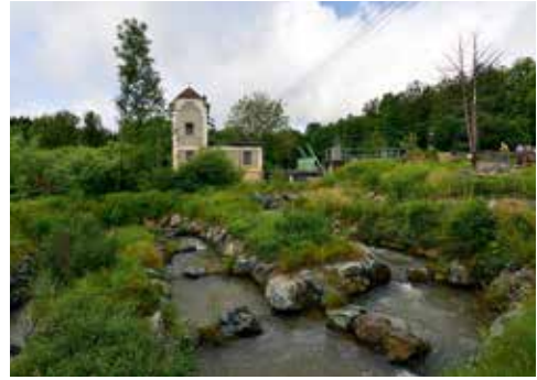
Beckenpass beim Kraftwerk Mattesmühle an der Feistritz in Rudersdorf Foto: P. Weilgony
