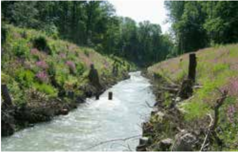
Abb. 8: Dynamisch dotierte Umgehungsarme von Sohlrampen der Salzach im Stadtgebiet von Salzburg. Der Mangel an Schlüssellebensräumen könnte durch eine deutliche Verbreiterung des Gewässers und Schaffung großflächiger seichter Uferzonen behoben werden. Auch die Einströmöffnungen (Stahlrohrdurchlässe) sollten umgebaut werden (siehe Text).
