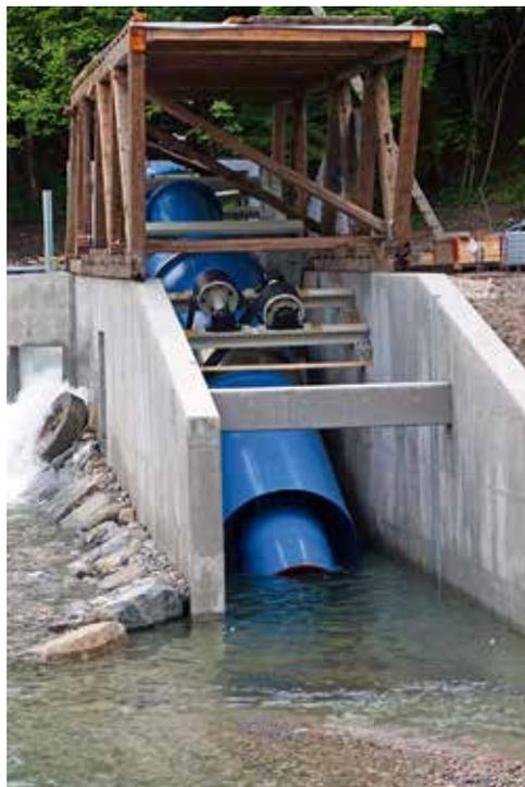
FAS vom Typ Hydro-Connect am Beispiel der Anlage an der Jessnitz (in Bau). Foto: Clemens Ratschan
