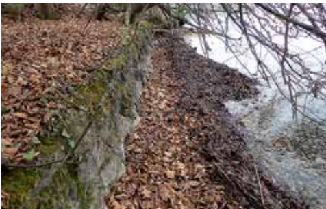
Abb. 7: Mit Beton verfugte Steinmauer an einem Grundstück in Nussdorf am Attersee vor dem Umbau.
