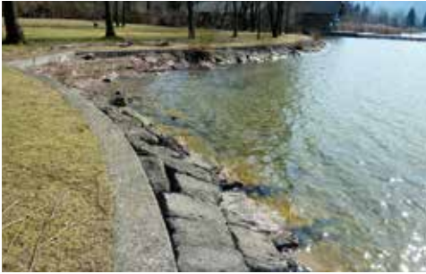
Abb. 1: Mit Beton und Blöcken verbautes Seeufer am Mondsee
