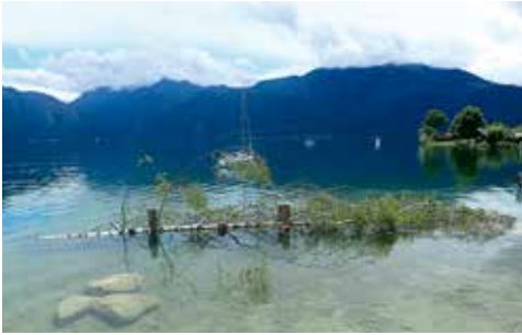
Abb. 9: Mit Piloten verankerter Raubaum in Unterach am Attersee als Erosionsschutz für das Ufer und Jungfischhabitat.
