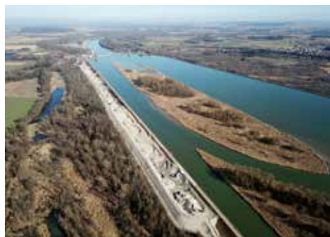
Abb. 12: In Bau befindliches Umgehungsgewässer. Bei einem Basisabfluss von 2 m 3 /s und dynamischer Dotation bis 12 m 3 /s wird es mit dem Innzubringer Mattig vergleichbar sein. Durch eine unterstromige Anbindung des Altarmsystems (links im Bild) wird dieses im Sinne autentischer Wasserstandsschwankungen dynamisiert. Foto: W. Lauber
