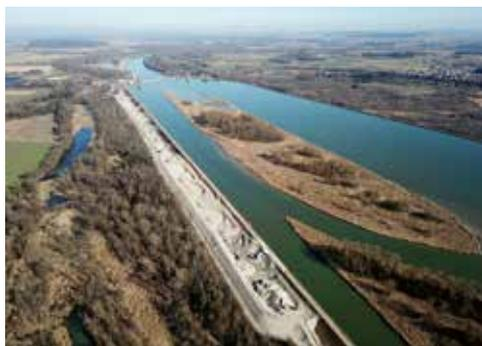
**Abb. 12:** In Bau befindliches Umgehungsgewässer. Bei einem Basisabfluss von 2 m<sup>3</sup>/s und dynamischer Dotation bis 12 m<sup>3</sup>/s wird es mit dem Innzubringer Mattig vergleichbar sein. Durch eine unterstromige Anbindung des Altarmsystems (links im Bild) wird dieses im Sinne autentischer Wasserstandsschwankungen dynamisiert. Foto: W. Lauber
