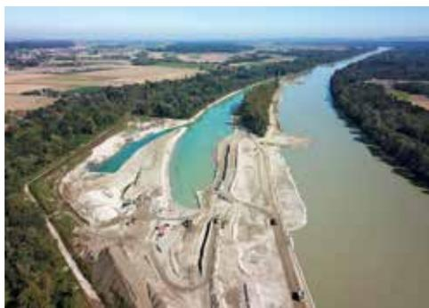
**Abb. 10:** Insel-Nebenarmsystem vor der Öffnung des durchströmten Nebenarms. Die Steingreßlinge wurden im Bereich der oberen Feinsedimentvorschüttung (Bildmitte) gefangen. Foto: W. Lauber
