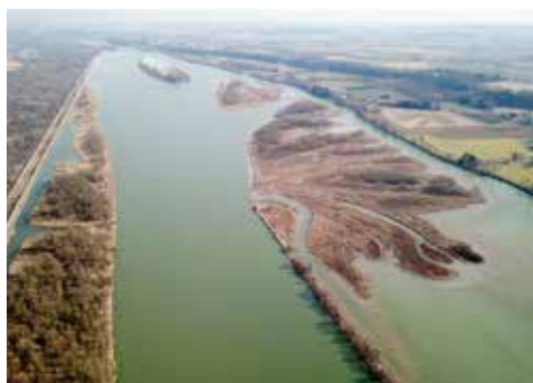
Abb. 6: Zentraler Stauraum des Kraftwerks Eggfling-Obernberg mit ausgedehntem Verlandungsbereich und mit Schilf und Gehölzen bewachsenen Feinsedimentinseln. Blickrichtung stromab. Foto: W. Lauber
