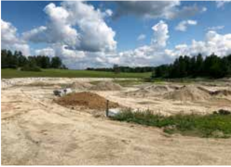
Abb. 1: Teichbaustelle im August 2019 (Quelle: BAW – Ökostation)
