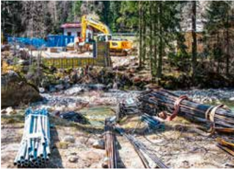
Bauarbeiten an der Öztaler Ache Ende März Foto: © by © Pistyll Productions
