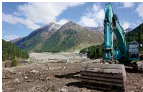
Vorarbeiten für die Kraftwerkserweiterung Kühtai, Längental, Ende Mai 2020 © Anna Schöpfer
