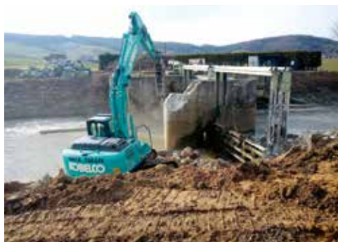
Abb. 2: Abbruch der Wehranlage in Abstetten im Jahr 2019
