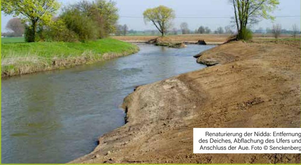
Renaturierung der Nidda: Entfernung des Deiches, Abflachung des Ufers und Anschluss der Aue. Foto © Senckenberg
