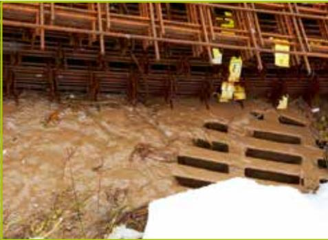
Baustellen in Gewässernähe bergen immer ein Risiko. In diesem Fall wird das stark verschmutzte Wasser aus einer Baugrube in den nächstbesten Kanal gepumpt. Dabei handelt es sich aber um einen Oberflächensammler der nach wenigen Metern in einen kleinen Bach mündet.
