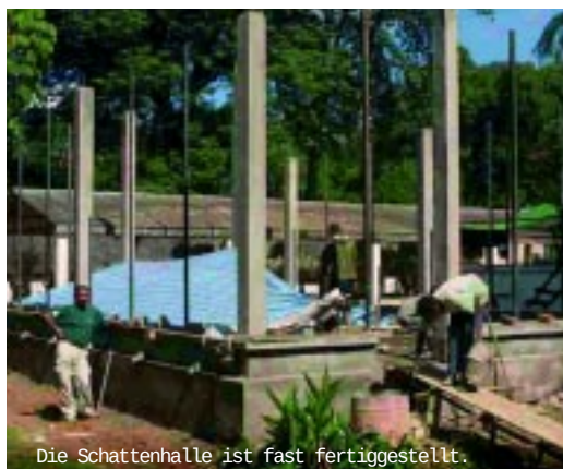
Die Schattenhalle ist fast fertiggestellt.
