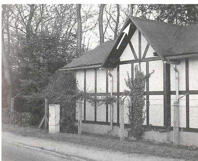
Abb.16. Hans-Neupert-Straße/Endstelle der Straßenbahn; Nest auf Firstbalken unter der Dachkante. Foto: Mai 2002.
