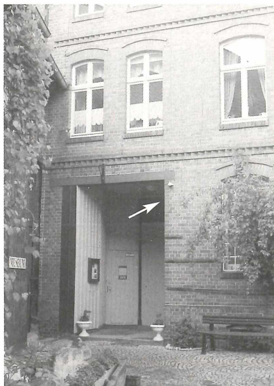
Abb.17. Vogtei/Kunsthof, Eingang zum Schraube-Museum; typischer Neststandort innen in einer Maueröffnung an der rechten Seitenwand. Foto: 01.06.2001.
