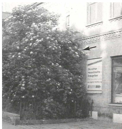
Abb.13. Spiegelstraße bei ehemaliger Fleischfabrik. In der Fassade neben dem großen Schild brütete der Hausrotschwanz erfolgreich hinter der Abdeckung eines Lüfters. Nachdem der hochgewachsene Holunder Sambucus nigra den Anflug versperrte, wurde der Nistplatz aufgegeben. Foto: 01.06.2001.
