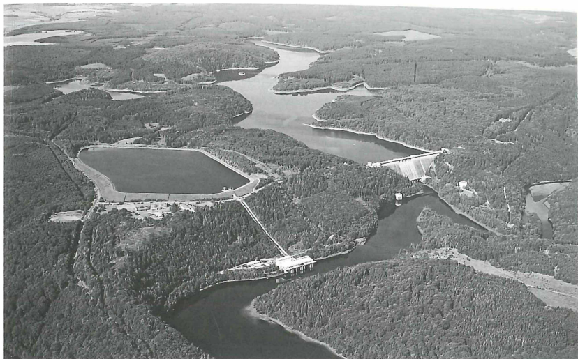
Abb.1. Blick nach Südwesten auf das Oberbecken Wendefurth (Bildmitte links), die Staumauer mit der sich dahinter erstreckenden Rappbodetalsperre (Bildmitte rechts) und die Talsperre Wendefurth (Vordergrund). Foto: Juli 2004, Talsperrenbetrieb Sachsen-Anhalt.
