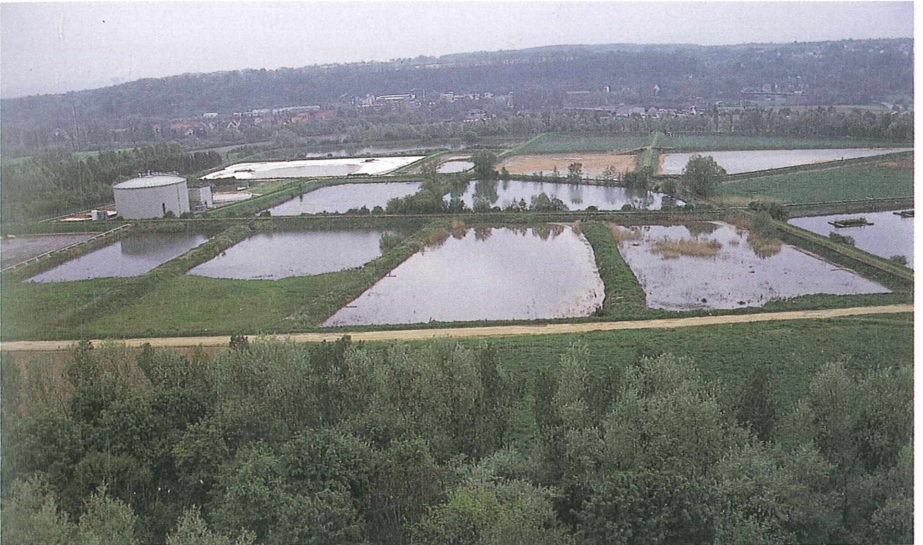
Foto 2. Die Klärteiche des Südzuckerwerkes Offenau. Ansicht vom Zuckersilo aus.
