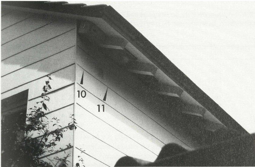
Abb. 5. Vergleich der Anbringung der Mauersegler-Nistkästen: Herkömmlicher Mauersegler-Nistkasten (Brutplatz 10) und Mauersegler-Nistkasten „Modell Rögelein“ (Brutplatz 11). Unter dem Dachvorsprung schließen sich Mehlschwalben-Doppelnester über die gesamte Dachfront an.
