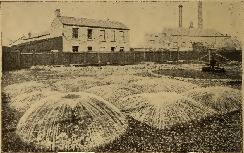
Abb. 3. Streudüsen, System Adams (aus Schiele, „Abwässerbeseitigung von Gewerben und gewerbereichen Städten“, in Mitteilungen der Königl. Prüfungsanstalt für Wasserversorgung und Abwässerbeseitigung, Heft 11, 1909).
