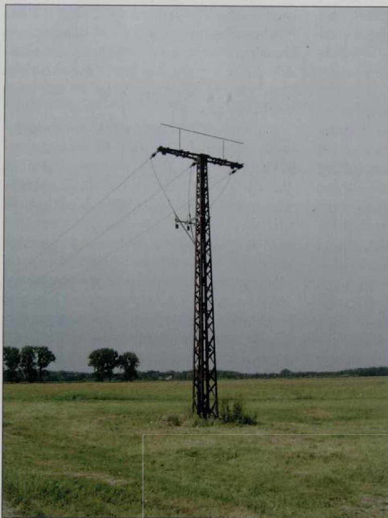
Abb. 5: Sitzstangen für Greifvögel und Störche schützen meist nicht hinreichend vor Stromschlag. Unter diesem Mast bei Nennhausen (Landkreis Havelland) wurde am 02.09.2005 ein Mäusebussard gefunden. Foto: T. Langgemach.
