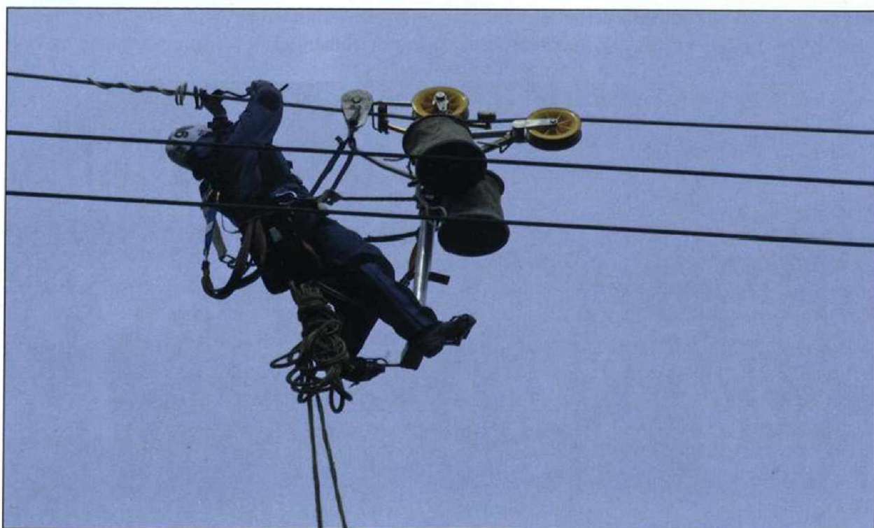
Abb. 2: Markierung der 220-kV-Leitung im Europäischen Vogelschutzgebiet „Havelländisches Luch“.
