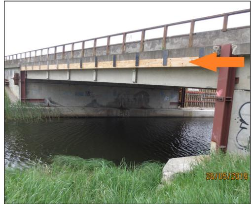
**Abb. 13:** An einer Autobahnbrücke angebrachtes Schutzbrett.
