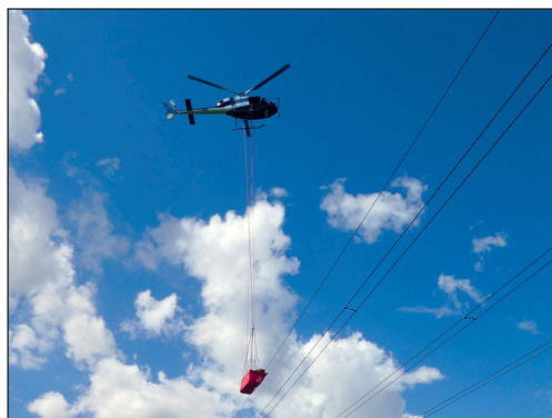
Abb. 6 und 7: Installation der schwarz-weißen „Zebra-Markierungen“ der Firma RIBE und Entfernung der vorhandenen Spiralen – perfektes Zusammenspiel des Leitungsbetreibers 50Hertz und der französischen Firma Airtelis im SPA „Havelländisches Luch“.
