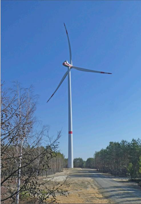
**Abb. 2:** Im Sommer 2019 errichtete Windenergieanlage des Typs „Vestas V136“ im Windpark bei Spremberg, März 2020.
