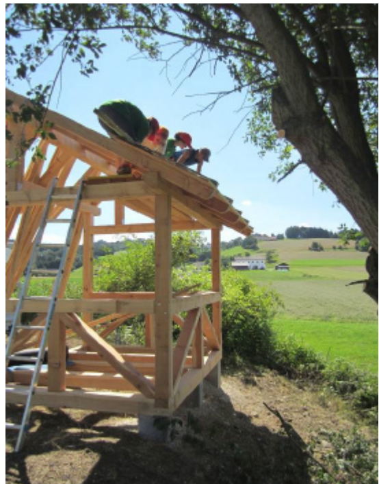
Beim Bau der Aussichtsplattform war Schwindelfreiheit und handwerkliches Geschick durchaus erforderlich.
