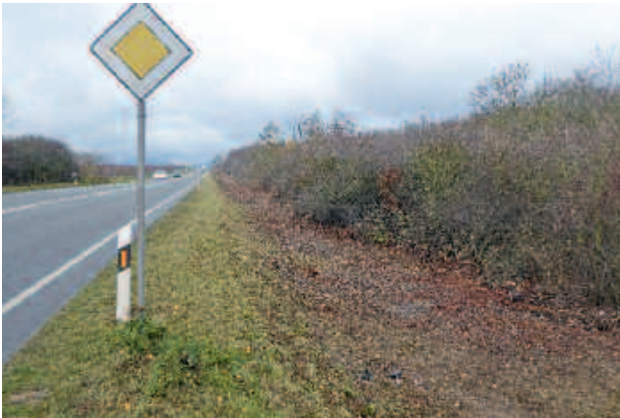
Abb. 1: Mahd des nördlichen Straßenrandes der B 38 bis in einen Heckenstreifen hinein (NSG Ebenberg). (Foto: M. Geiger)
