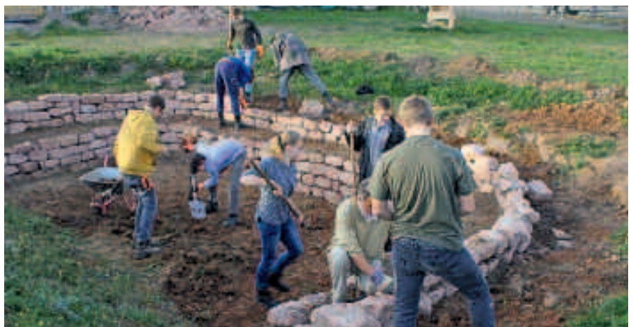
Bau der Trockenmauer an der Versickerungsmulde. (Foto: G. Hahn)
