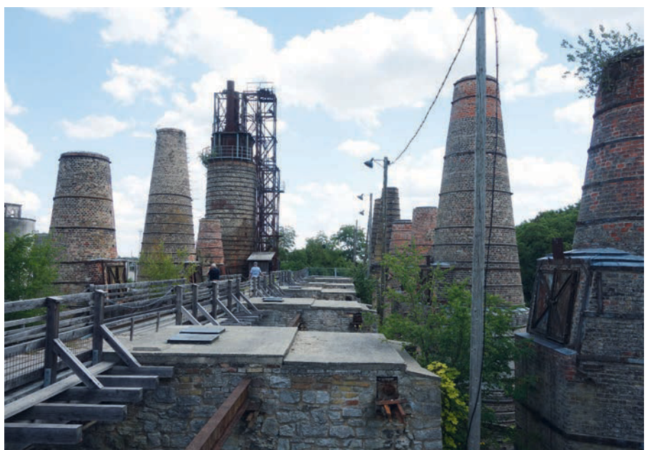
Abb. 2: Rüdersdorf, Schachtofenbatterien mit Beschickungsebene.
