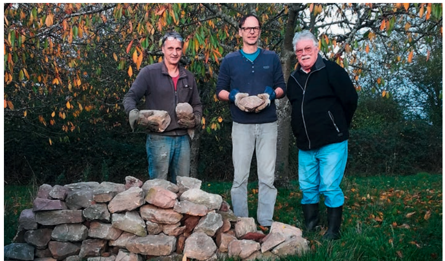
Abb. 2: Thorsten Griebel (l.) und Michael Ochse (m.) nach dem Errichten der Steinmauer für die Schlingnatter. Daneben Horst Geyer (r.), der Entdecker der Schlingnattern in seinem Garten.
