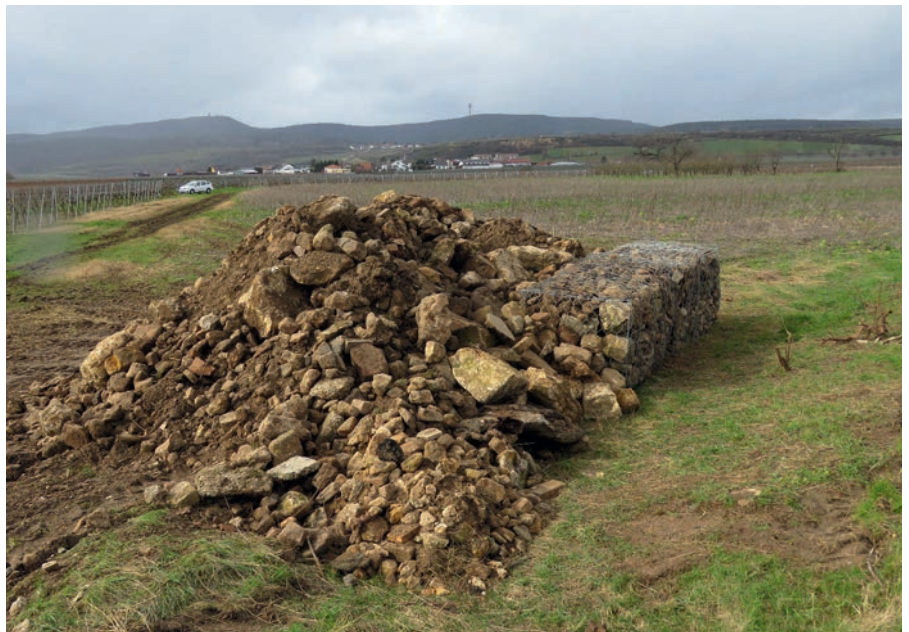
Abb. 1: Eine der sechs neuen Gabionen in Kallstadt.
