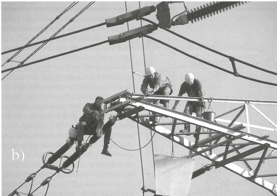
Abb. 6 b: Kotverkrustungen auf den Isolatoren werden beseitigt, nach dem Entfernen des Abwehrbleches wird das Gestänge überprüft und gereinigt. – Budenheim, 1.9.2004 (Fotos: I. Dörner)
