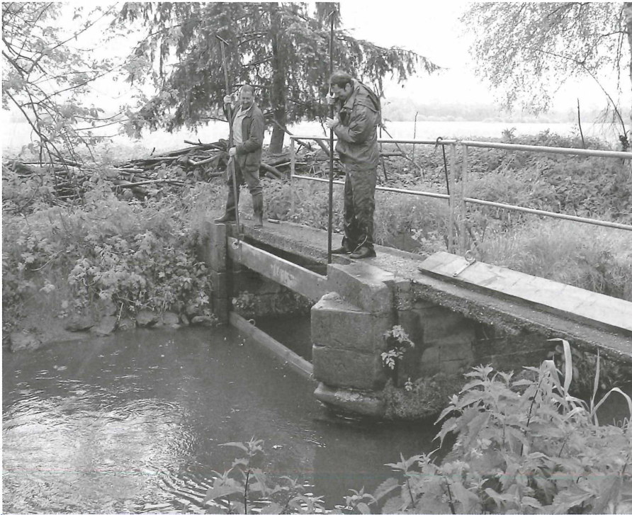
Abb. 2: Rödelwehr – Alte Technik durch Anstau mit Hand.
