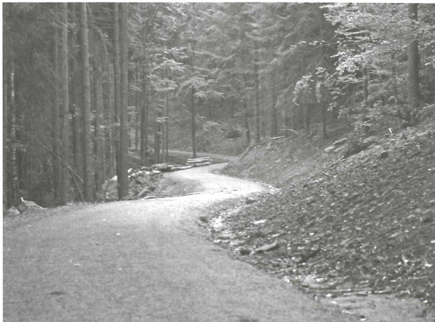
Abb. 7: Fahr- und Wanderweg vom Dreimärker zur Landauer Hütte, ausgebaut 2007. Die Wegeoberfläche wurde mit Brechsand veredelt, da der Weg auch Wanderwegsfunktion hat. Gut zu erkennen das Rundprofil mit bergseitigem Wassergraben, der in der Bildmitte durch eine Furt in den Wald entwässert. Die bergseitige Böschung ist noch in großen Teilen blank und bietet temporäre Rohbodenbiotope. Der Wegeverlauf kennzeichnet Flugschneisen. (Foto: S. Weiter, Forstamt Haardt)
