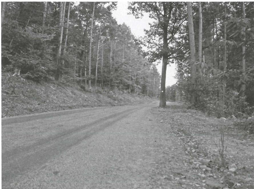
Abb. 5: Fahr- und Wanderweg vom Dreimärker zur Gleisweiler Hütte, ausgebaut 2007. Beispiel für das Einbeziehen natürlicher Gegebenheiten in den Wegeverlauf. Die Eiche wurde als markanter Baum in den Wegebau mit einbezogen. (Foto: S. Weiter, Forstamt Haardt)
