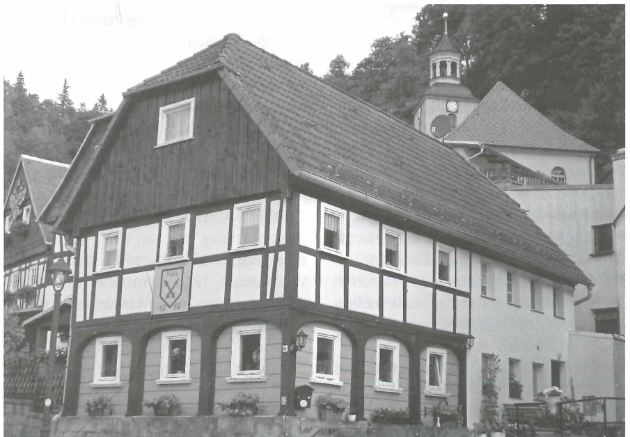
Abb. 2: In Bad Oybin: Umgebinderhaus und Bergkirche.
